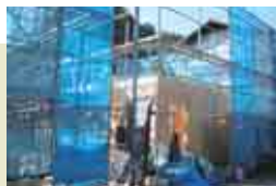
施行中の2×4住宅
