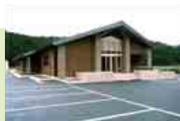
同社が施工したコミュニティセンター
