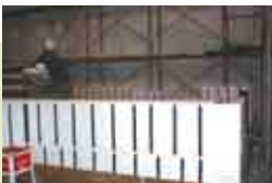
断熱型枠による建設現場。手前は発砲スチロール製の断熱型枠を組んでいる作業
