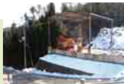
発電施設建設予定地(右手で雪に覆われているのが廃材)
