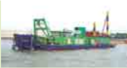
高濃度薄層浚渫圧送船「清宏VI」(95トン)
