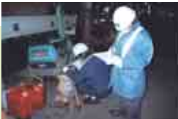
道路工事現場でのCO 2 の測定状況
