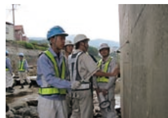
コンクリートのひび割れを調査
