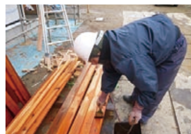
木材に防腐剤を塗る研修に取組む教員 (宮城県白石工業高等学校)
