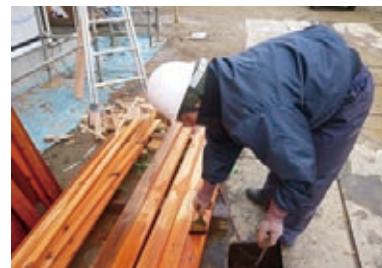
木材に防腐剤を塗る研修に取組む教員 (宮城県白石工業高等学校)
