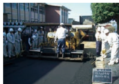
アスファルト舗装に取り組む生徒達 (栃木県立真岡工業高等学校)
