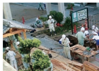
地元小学校のビオトープ構築には、小学生も参加した(兵庫県立東播工業高等学校)
