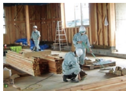
現場の清掃作業。木材の製材作業補助などを体験 (新潟県立新発田南高等学校)
