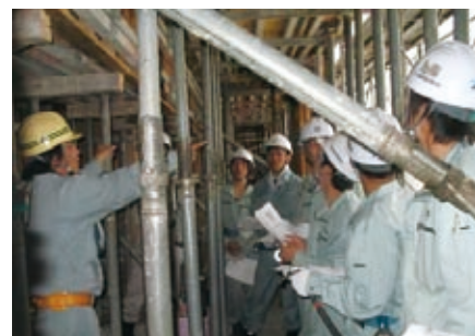
マンション建設現場で説明を受ける生徒達 (兵庫県立東播工業高等学校)
