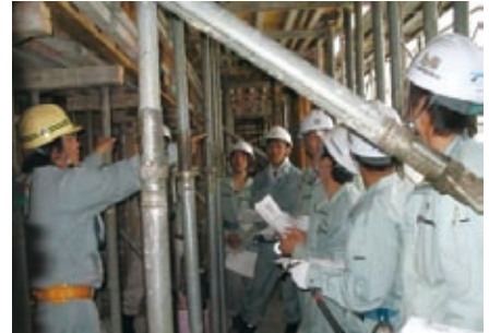
マンション建設現場で説明を受ける生徒達 (兵庫県立東播工業高等学校)
