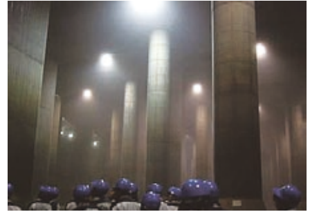
世界最大級の洪水防止施設、首都圏外郭放水路を見学 (栃木県立今市工業高等学校)
