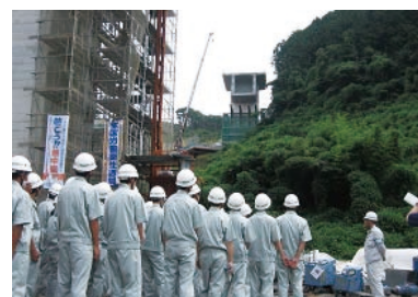
西九州自動車道の建設工事現場を見学 (長崎県3校の合同)
