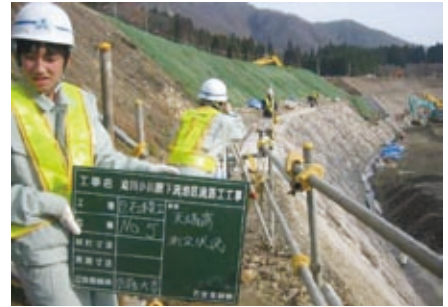
災害復旧現場を撮影する生徒(宮城県古川工業高等学校)
