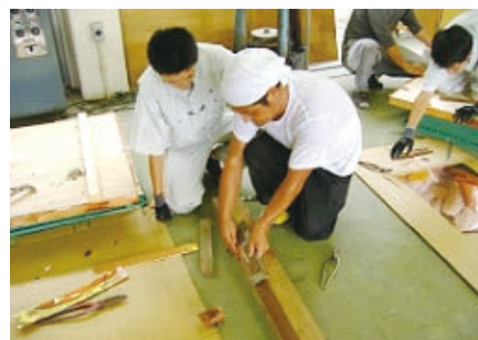
瓦棒ぶきの作成、折り曲げ加工の指導を受ける (栃木県立今市工業高等学校)
