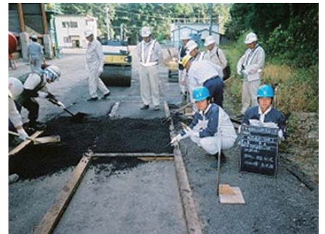
アスファルト舗装試験の実習風景 (今市工業高等学校)
