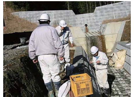
型枠作業の体験実習の様子（真岡工業高等学校）
