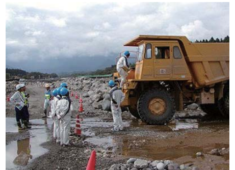
大谷川河川工事現場見学（今市工業高等学校）
