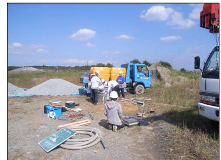
試験施工現場の様子
