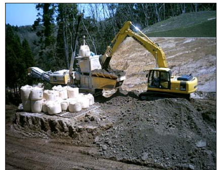
建設発生土リサイクルシステム（リテラ工法）に欠かせない自走式土質改良機。実際に、災害復旧工事でも活躍した
