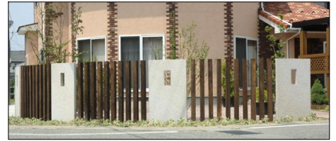
枕木スクリーンを配した施工例
