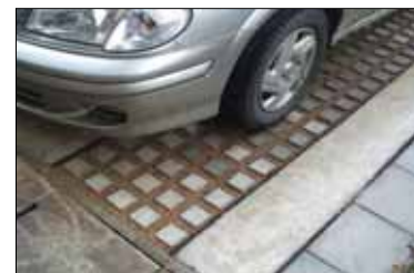
駐車場における実験施工
