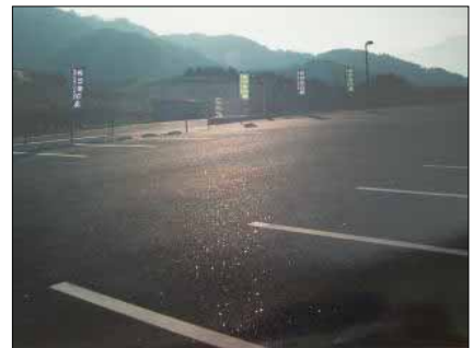
温泉施設の駐車場。「キララアスコン」で施工した事例。景観にマッチしたおしゃれな舗装として注目されている
