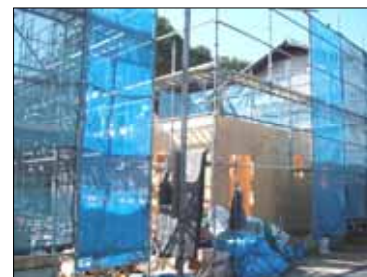
施工中の2×4住宅
