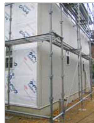
施工中の2×4フレーミング
